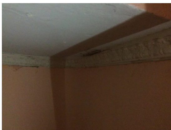
Danos internos nos acabamentos devido a infiltrações, 2018 (Fonte: acervo UFOP)
