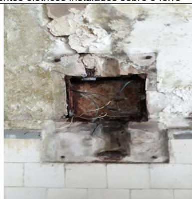
Instalações elétricas - Registro da situação dos cabamentos elétricos instalados nas paredes
