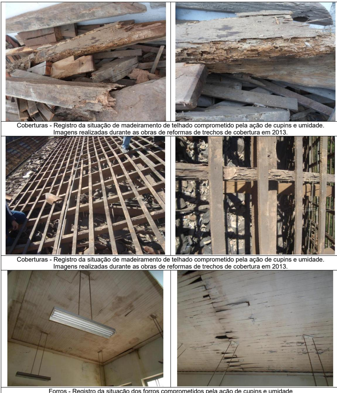
Coberturas - Registro da situação de madeiramento de telhado comprometido pela ação de cupins e umidade. Imagens realizadas durante as obras de reformas de trechos de cobertura em 2013.
