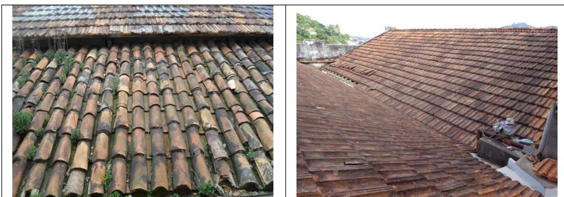
Coberturas - Telhas coloniais degradadas / coletores pluviais corroídos e incompatíveis
